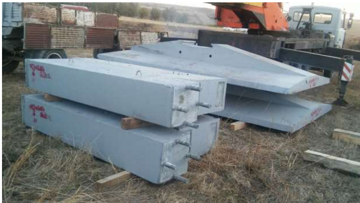
Рисунок 2 - Схема транспортировки сборных фундаментов по серии 3.407.1-144
